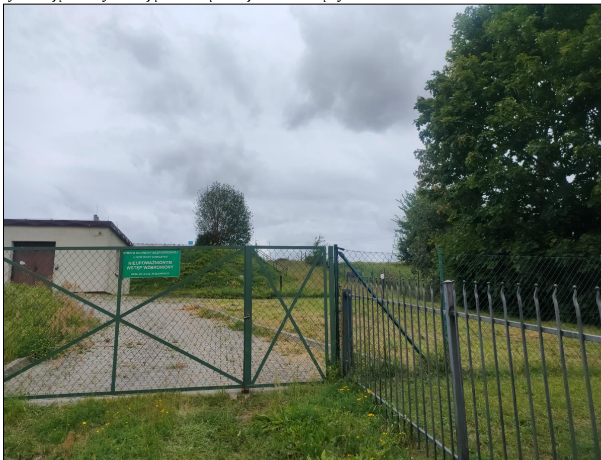
Ryc. 30. Ujęcie wody ze strefą ochronną w miejscowości Goręczyno
