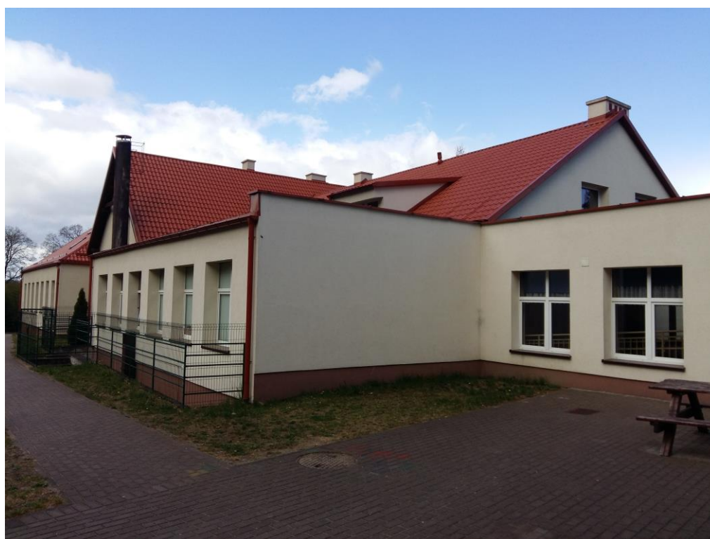
Lokalizacja kotłowni gazowej
