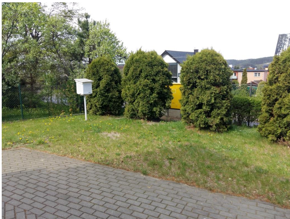
Lokalizacja skrzynki gazowej
