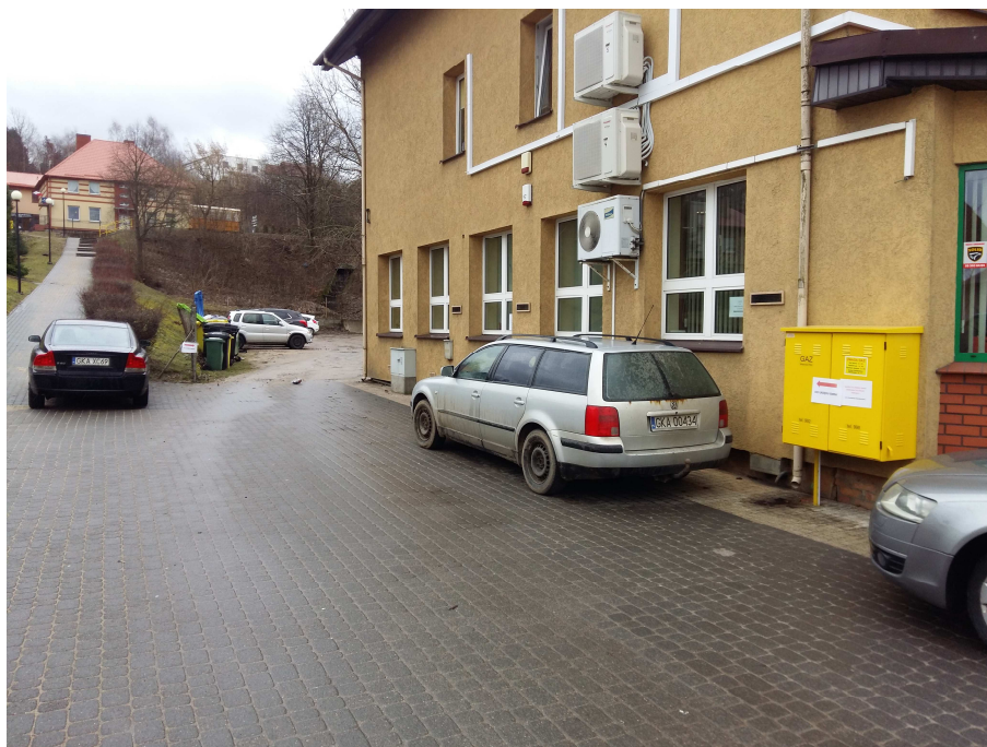
Lokalizacja skrzynki gazowej
