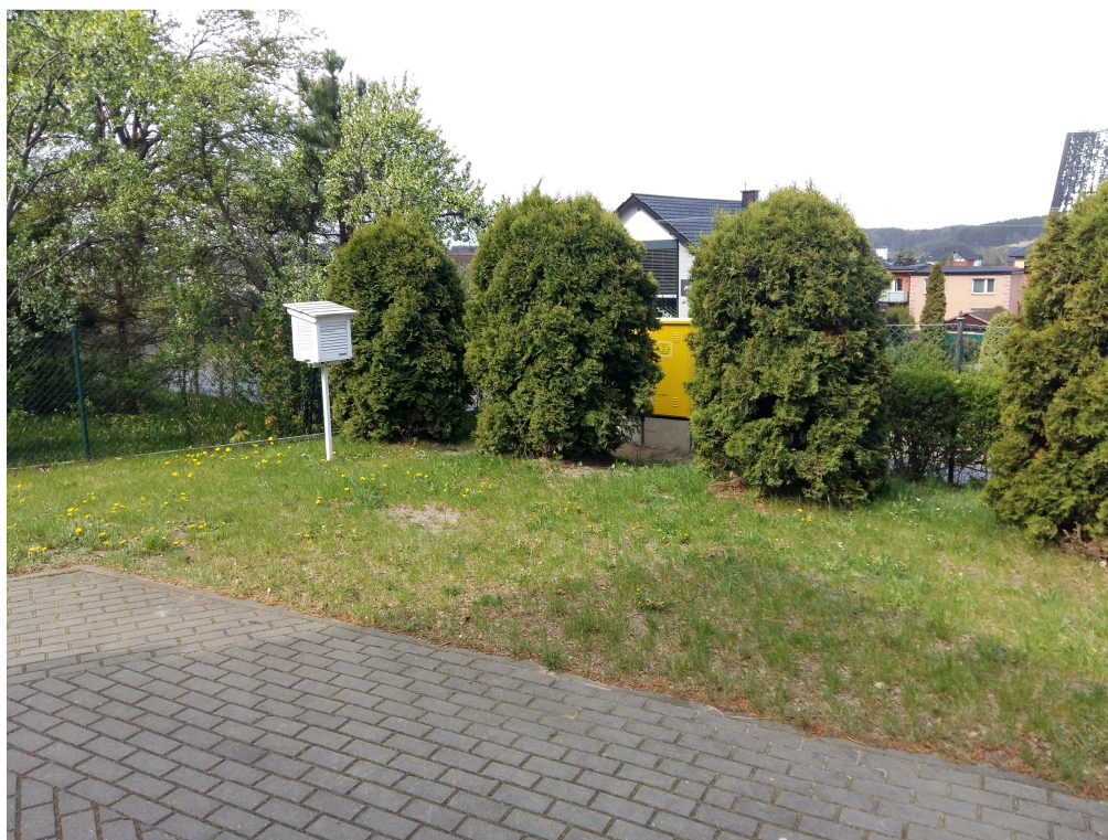
Lokalizacja skrzynki gazowej
