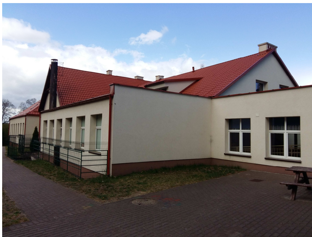
Lokalizacja kotłowni gazowej
