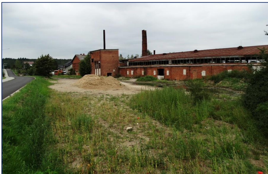
Fot. 1 Widok na zachodnią część terenu inwestycyjnego
