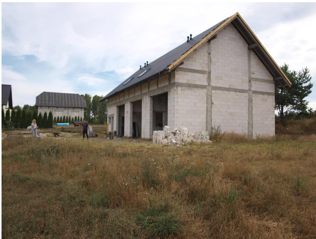
Fot. 2. Powstający budynek gospodarczo-usługowy
