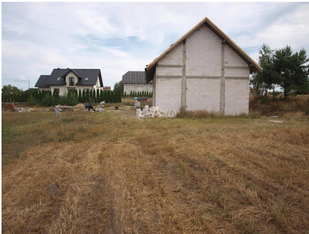
Fot. 1. Ściana budynku gospodarczo-usługowego, przy której ma być zlokalizowana kabina lakiernicza
