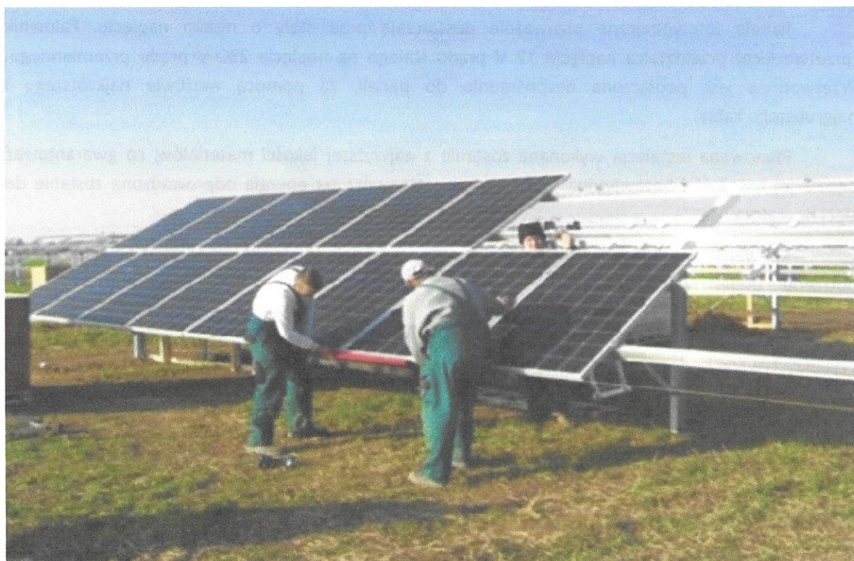
Ryc. 8. Montaż paneli
