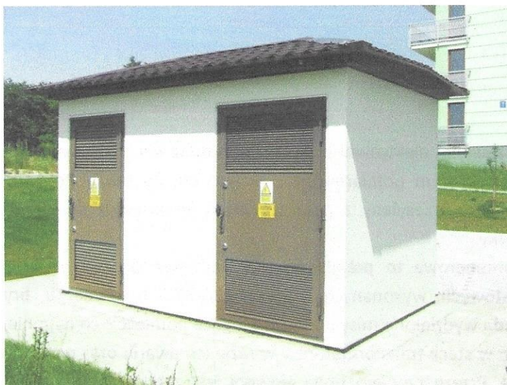
Ryc. 10. Przykładowa kontenerowa stacja transformatorowa
