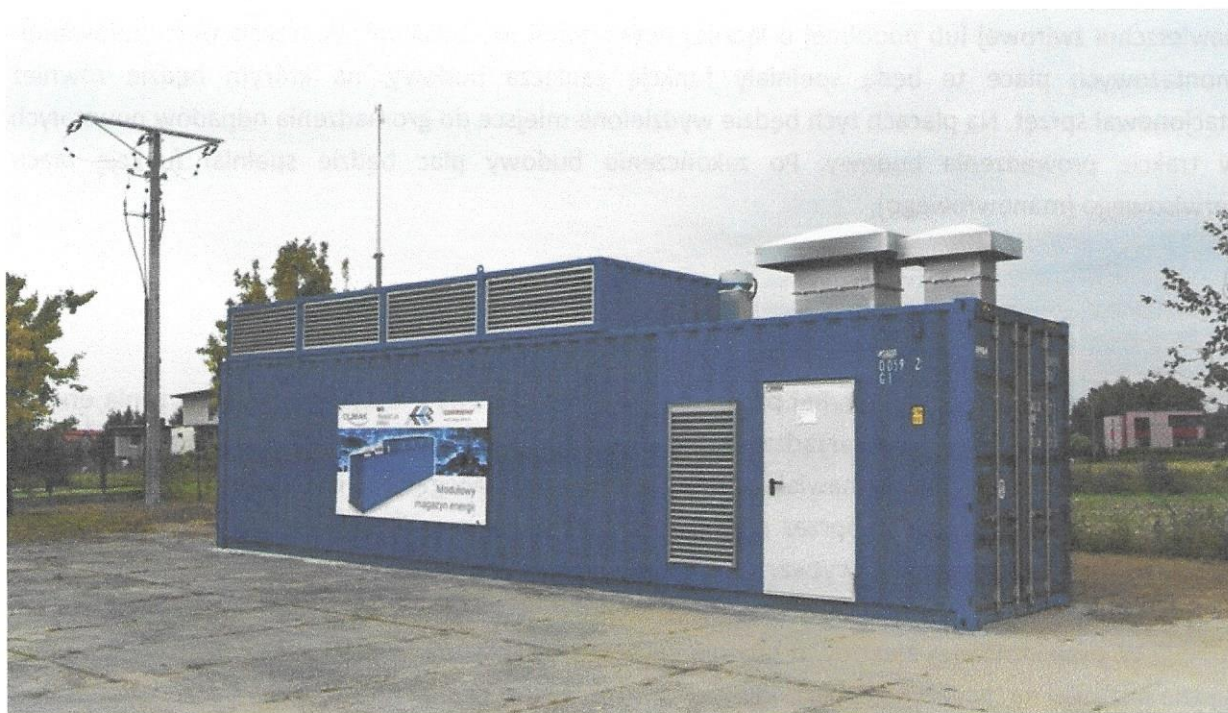
Rycina 11. Modułowy (kontenerowy) magazyn energii który będzie zastosowany w planowanej elektrowni.
