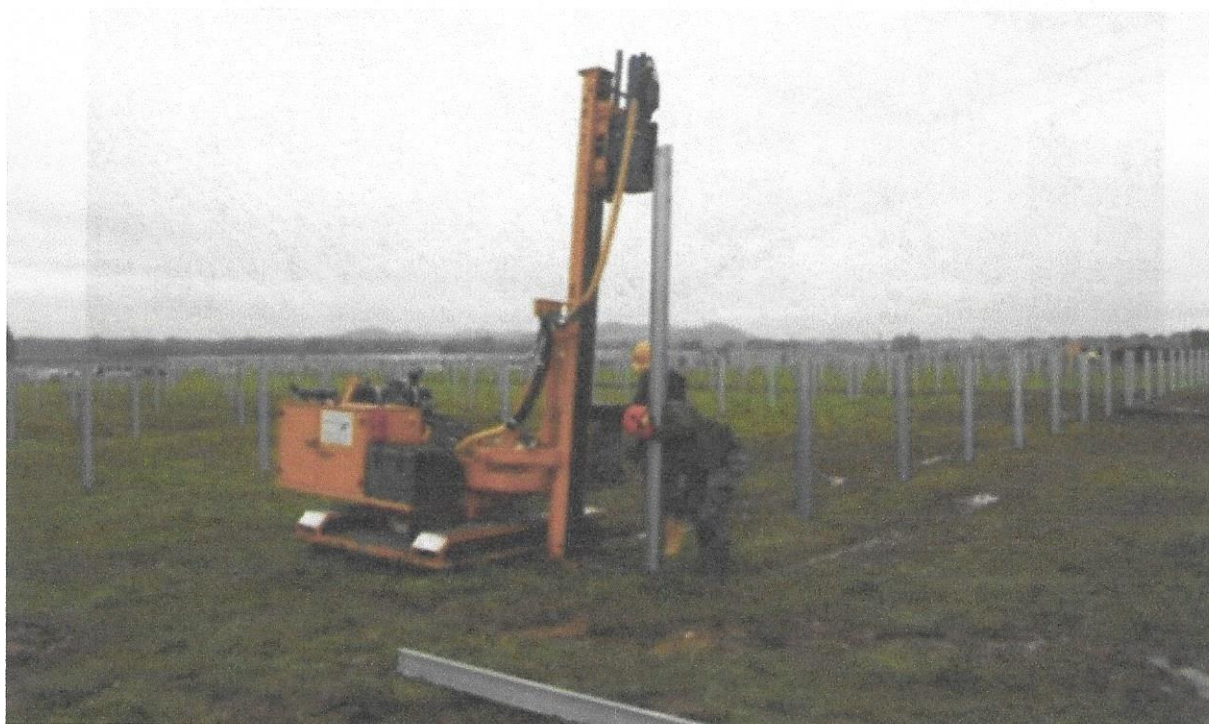
Ryc. 6. Przykładowy montaż konstrukcji gruntowej wraz z panelami: Palowanie
