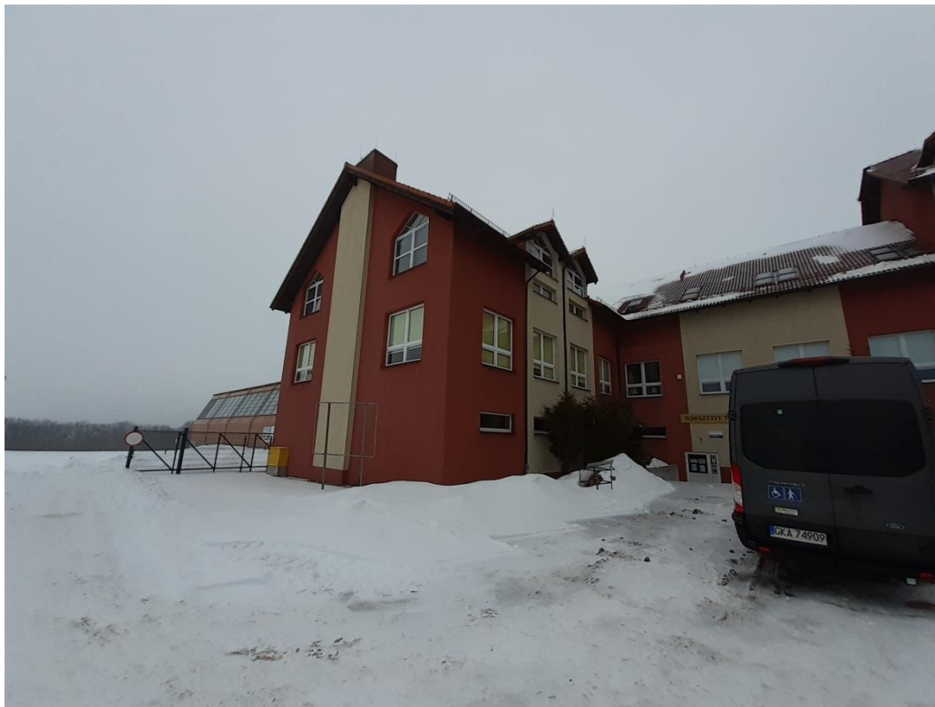
Skrzydło szkoły z pomieszczeniem kotłowni
