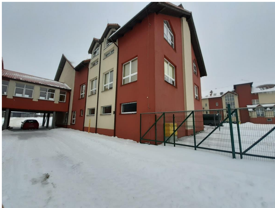
Skrzydło szkoły z pomieszczeniem kotłowni
