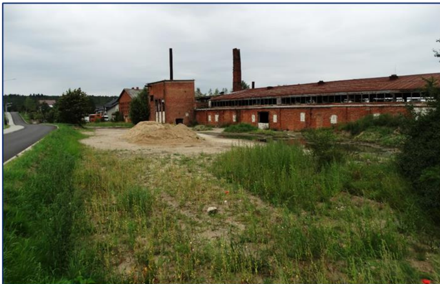
Fot. 1. Widok na zachodnią część terenu inwestycyjnego
