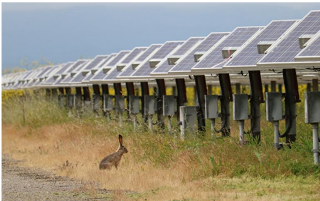
Fot. 4 Odpowiednio wykonane ogrodzenie farmy fotowoltaicznej zapewnia możliwość migracji i żerowania małym i średnim zwierzętom (Źródło: https://www.rpcs.com/wp-content/uploads/2019/03/Solar-and-Wildlife_RPCS.pdf )
