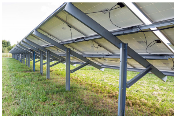
Rys. 3.5. Przedstawienie przykładowych konstrukcji pod panele fotowoltaiczne
