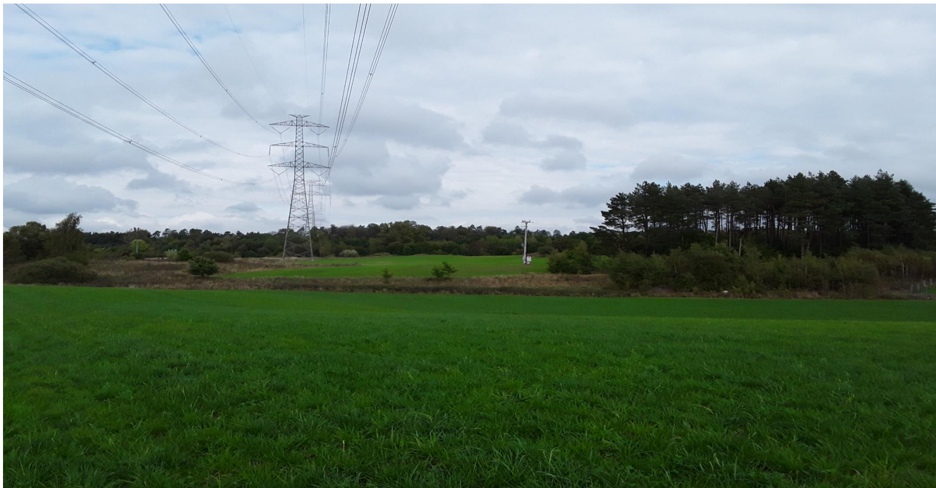
Fot. 22 Teren inwestycji, panorama w kierunku północno wschodnim (pkt 3)
