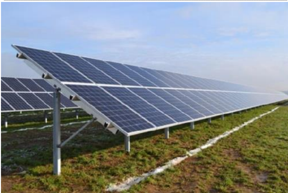
Fot. 6 Gotowa konstrukcja
