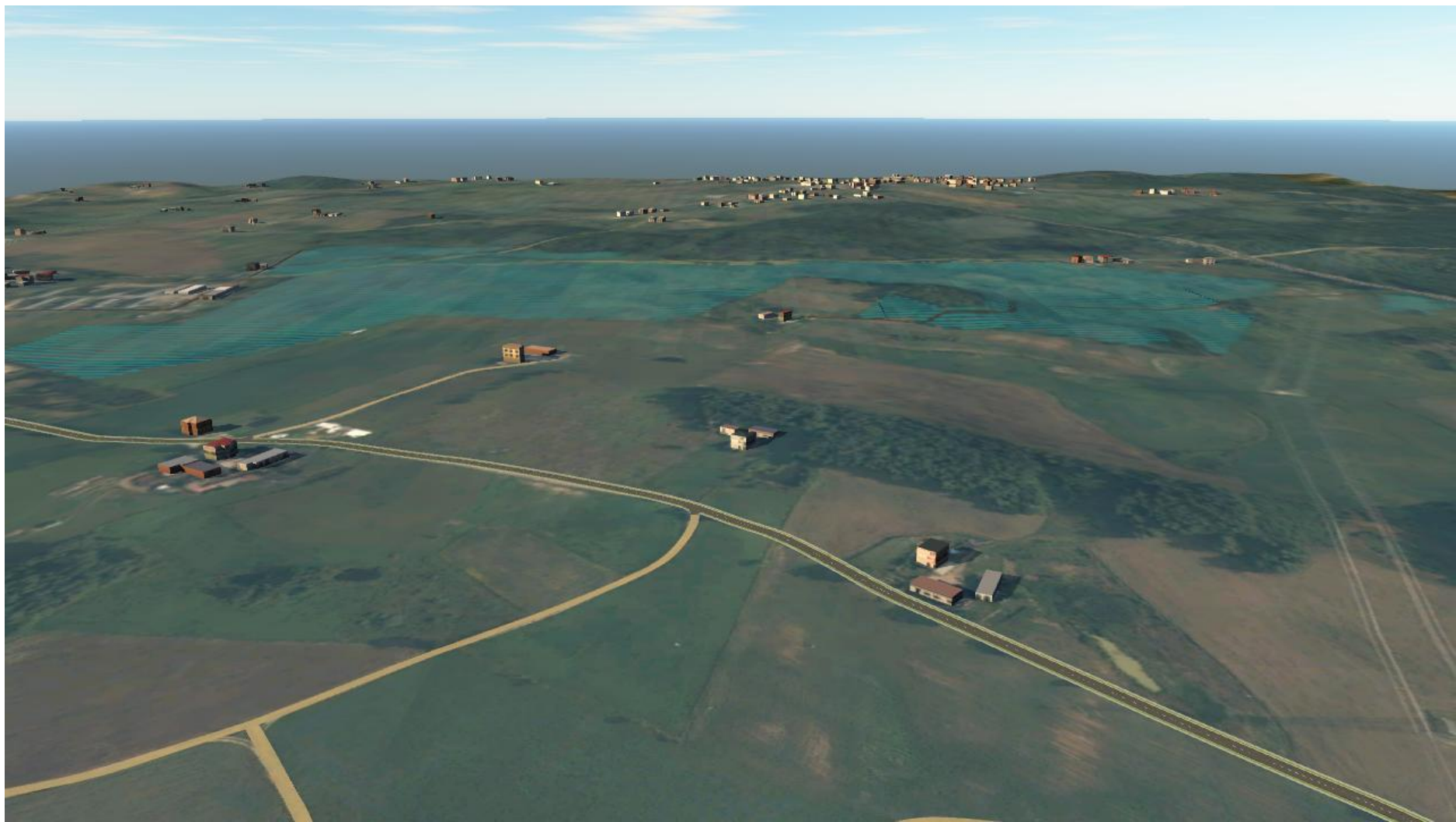
Rys. 31 Widok ogólny na farmę z lotu ptaka z wysokości ok. 200 m nad poziomem terenu w kierunku N (opracowanie własne)
