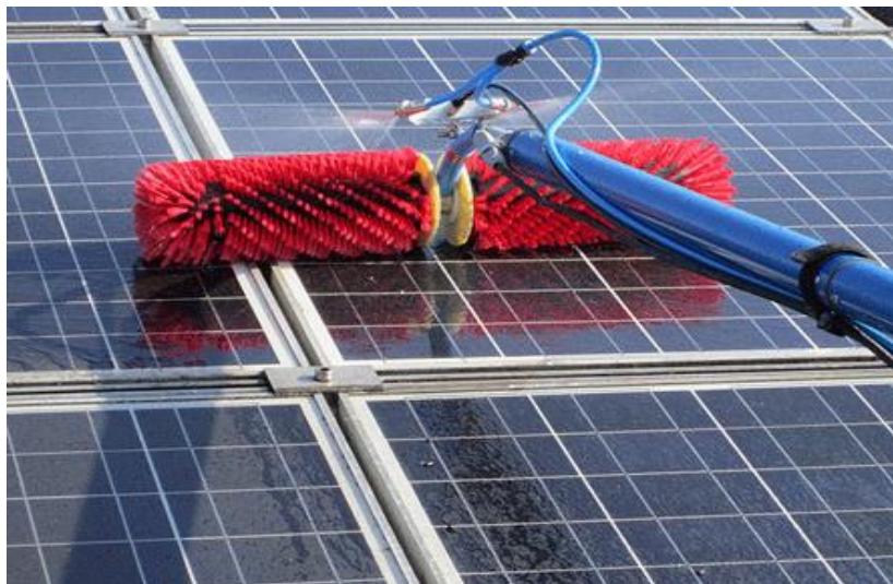
Fot. 2 Czyszczenie instalacji fotowoltaicznej
