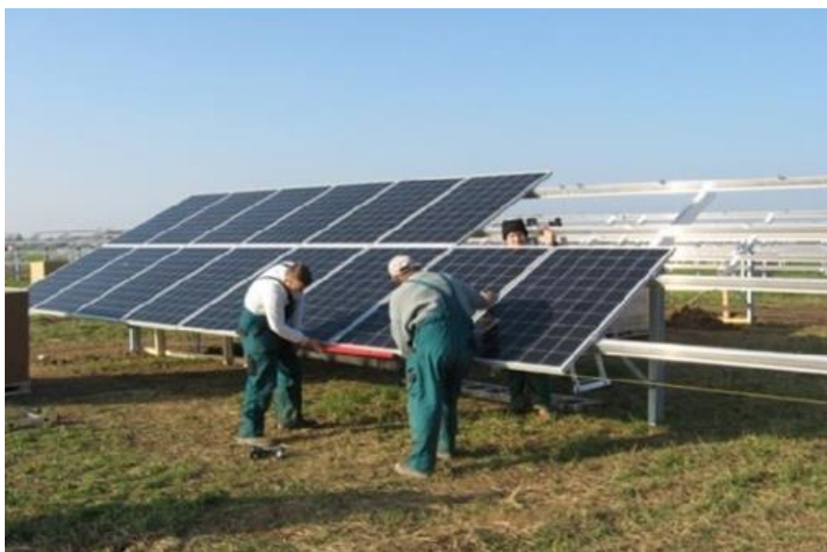
Fot. 5 Montaż paneli
