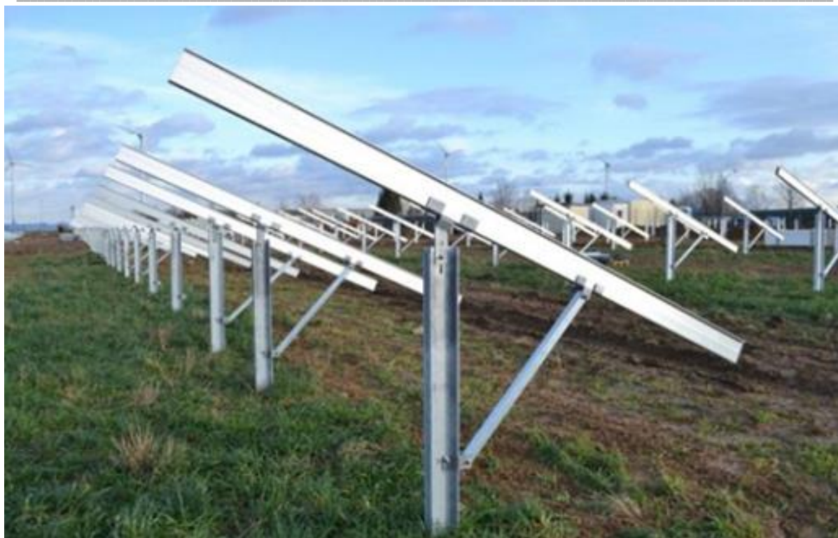
Fot. 4 Montaż konstrukcji
