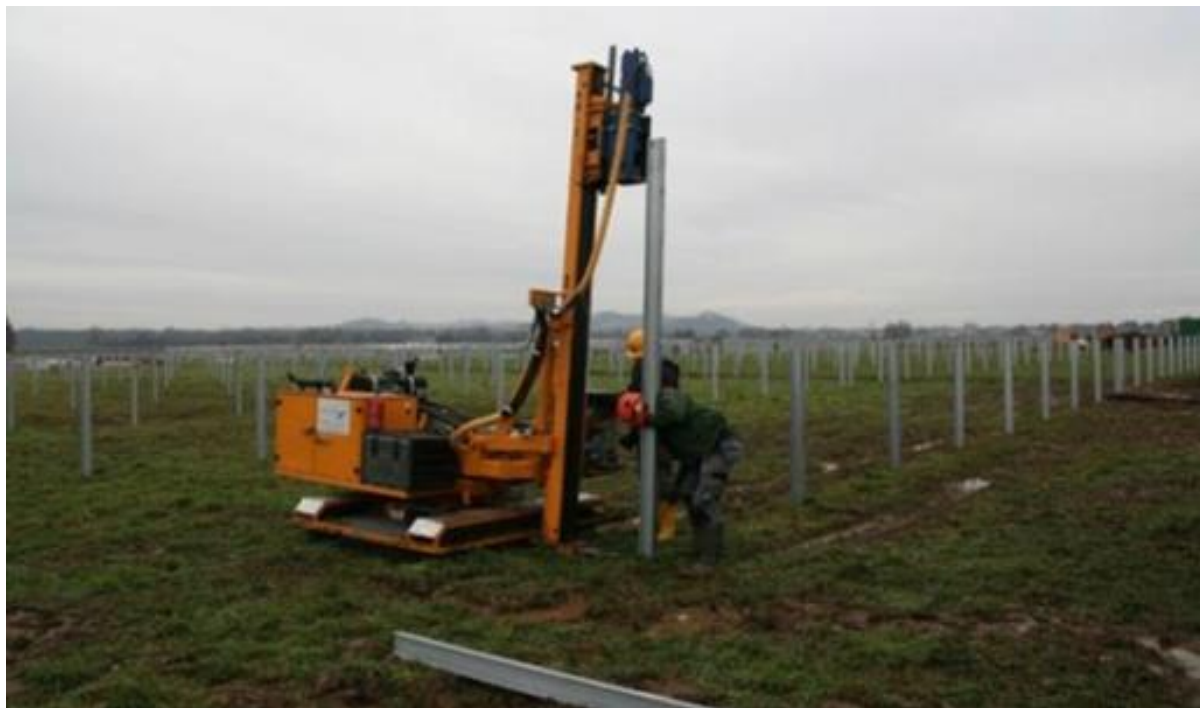
Fot. 3 Przykładowy montaż konstrukcji gruntowej wraz z panelami: Palowanie
