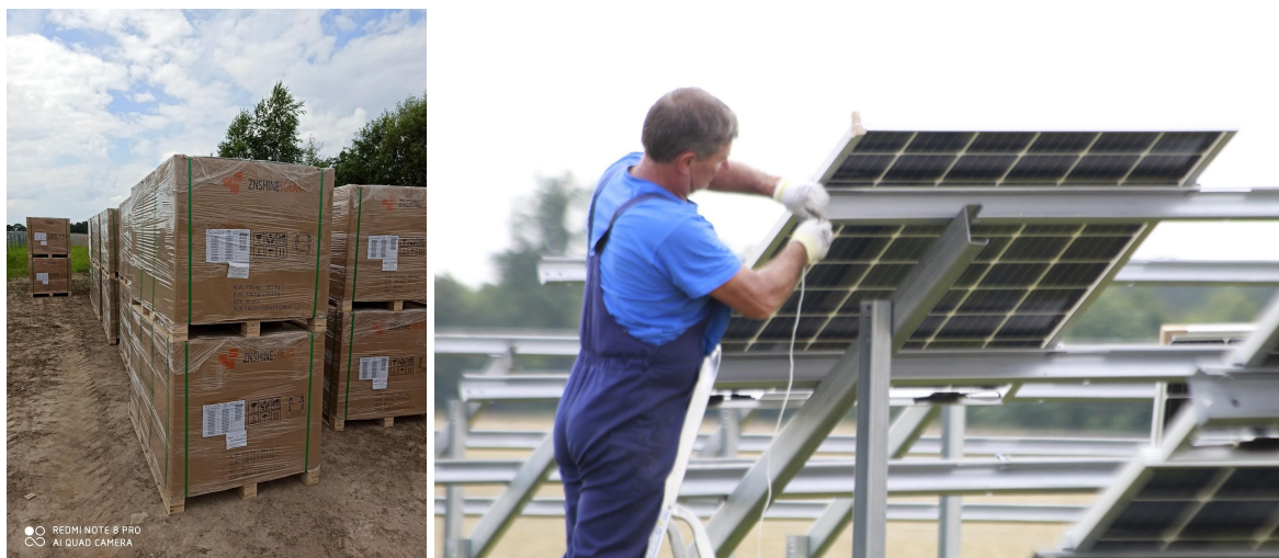
Zdj. Teren budowy - gotowe elementy farmy i ich montaż
