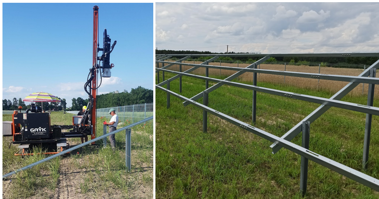
Zdj. Konstrukcja oparta o słupki wbijane w grunt
