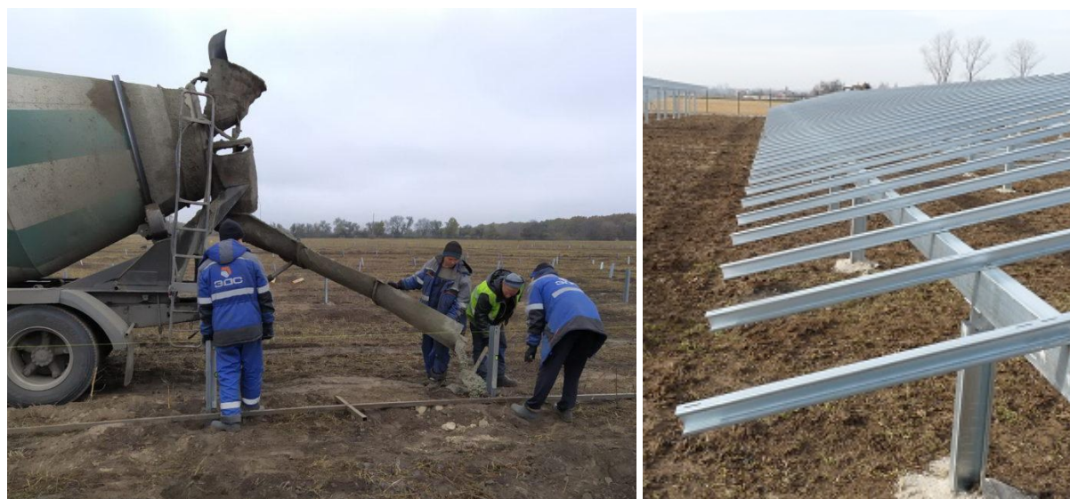
Rys. Konstrukcja zakotwiona w betonie
