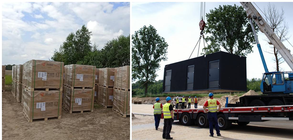
Zdj. Elementy farmy PV na placu budowy
