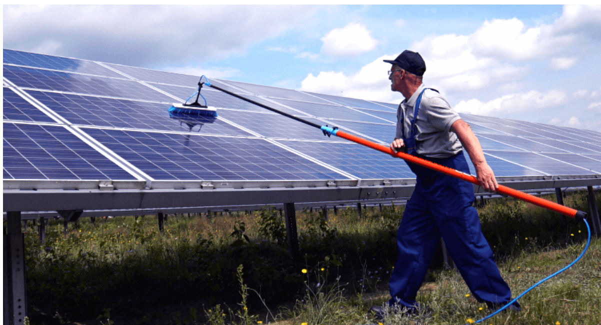
Zdj. Mycie paneli PV
