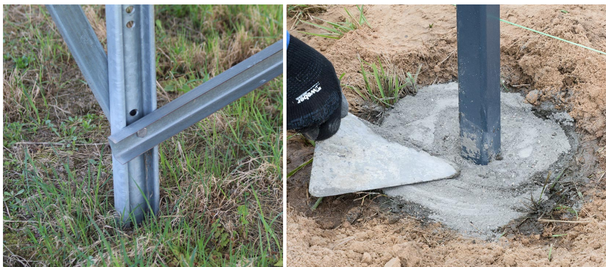
Zdj. Różnice w sposobie kotwienia - istotne z punktu oddziaływania na środowisko
