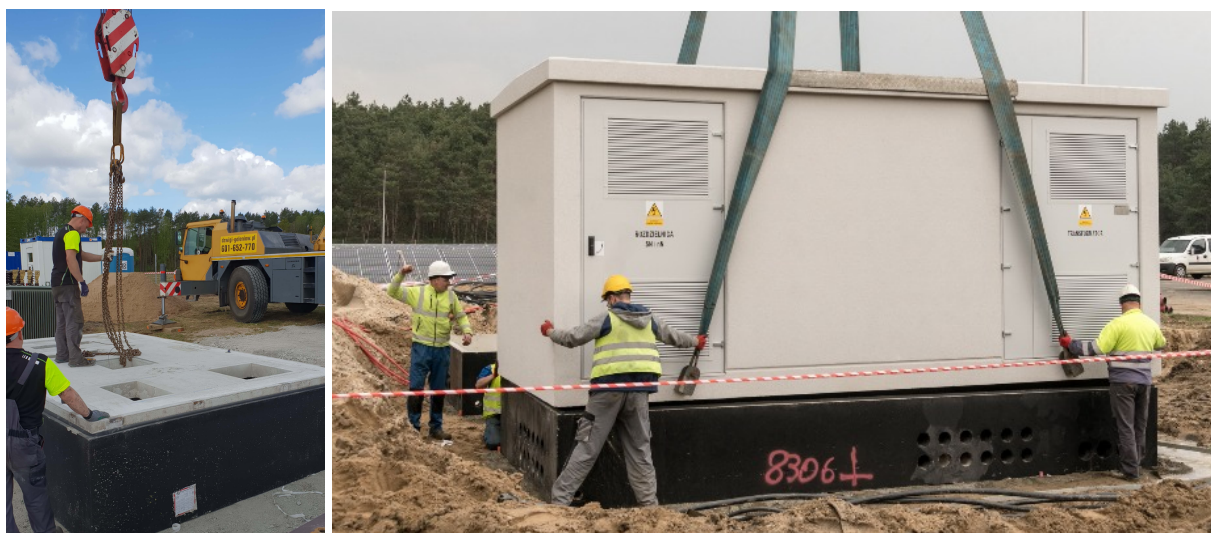
Zdj. Montaż płyty fundamentowej i stacji trafo na płycie fundamentowej
