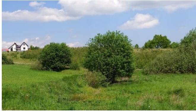
Fot. 12 Rów melioracyjny na działce 115/6
