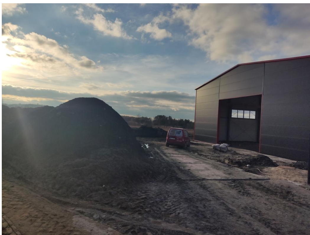
Fotografia 3 Prace budowlane prowadzone na terenie inwestycyjnym w oparciu o wydane pozwolenie na budowę (Fot. N. Lekner, dn. 15.03.23).
