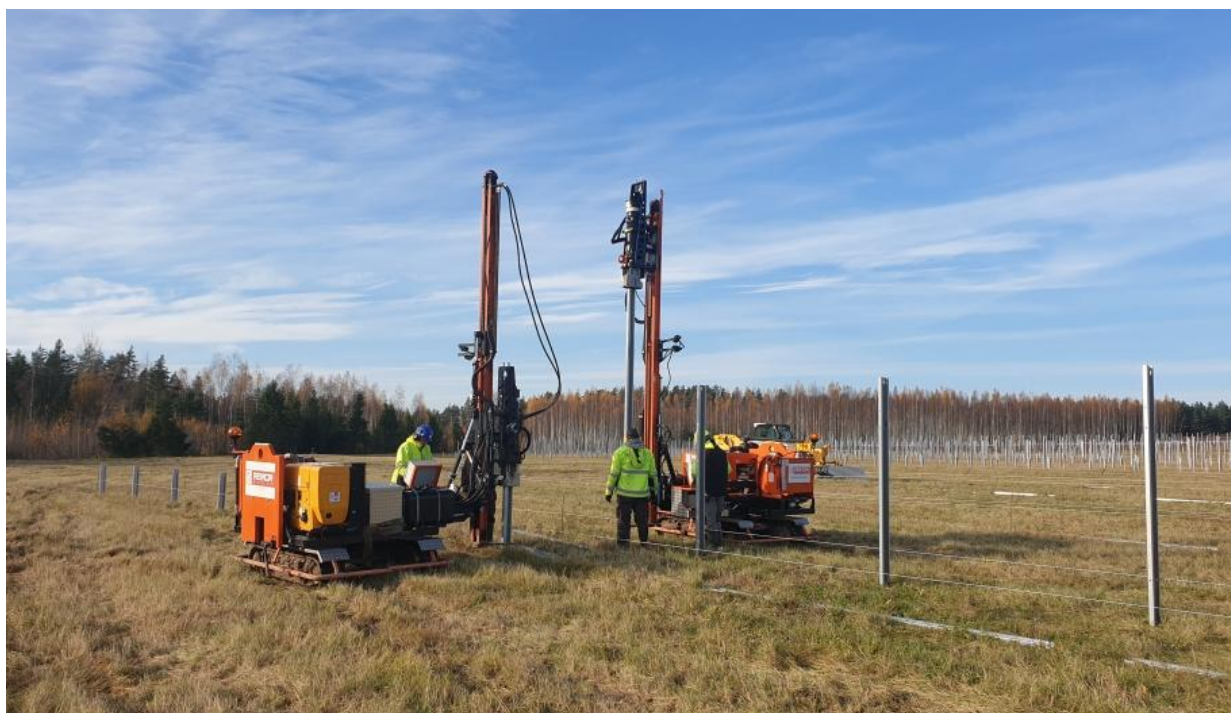
Zdj. 25 Proces wbijania słupków konstrukcji wsporczej
