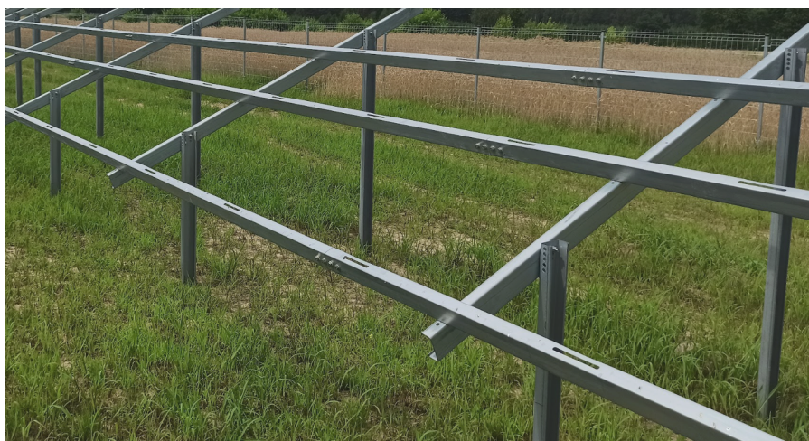
Zdj. 22 Szyna podtrzymująca konstrukcję PV wbita w rodzimy grunt.
