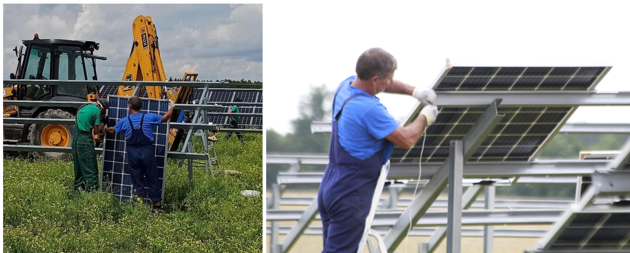
Zdj. 13 Teren budowy - montaż elementów farmy PV
