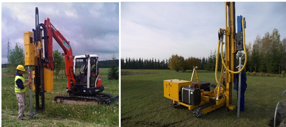
Zdj. 37 Kafar do wbijania słupów konstrukcji wsporczej
