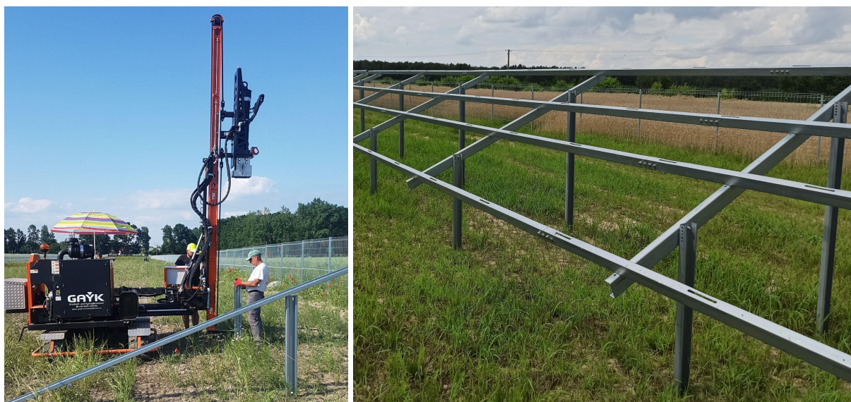
Zdj. 1 Konstrukcja oparta o słupki wbijane w grunt
