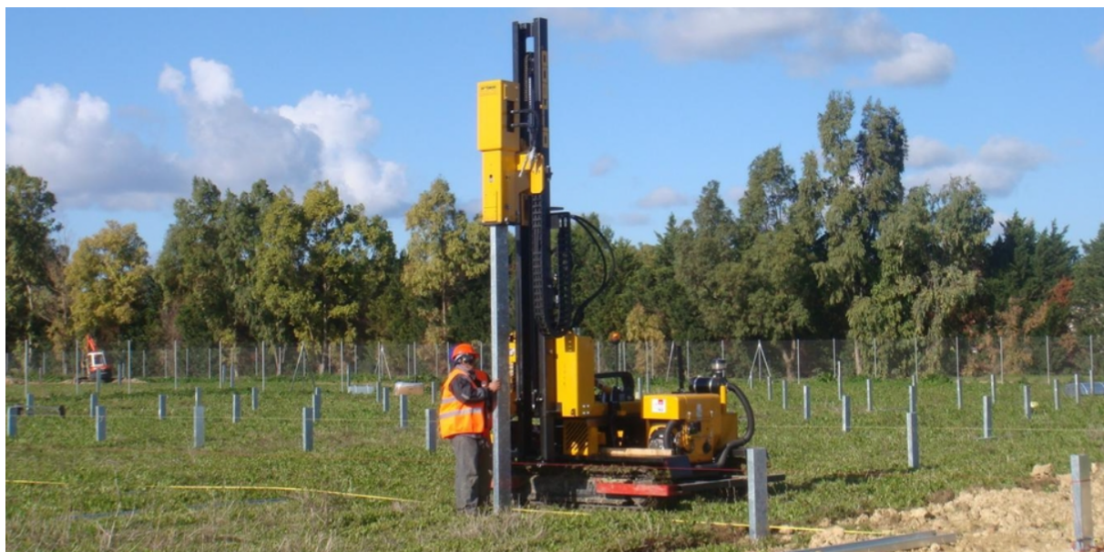
Zdj. 21 Wbijanie kafarem słupów pod konstrukcję wsporczą instalacji PV
