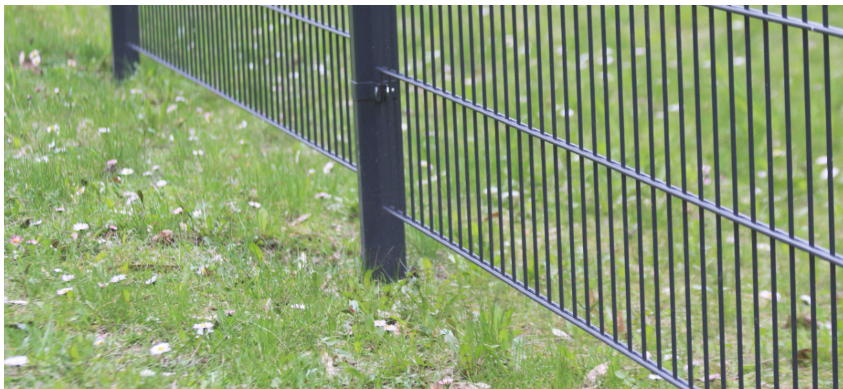
Zdj.6 Typowe wykończenie ogrodzenia na farmach PV
