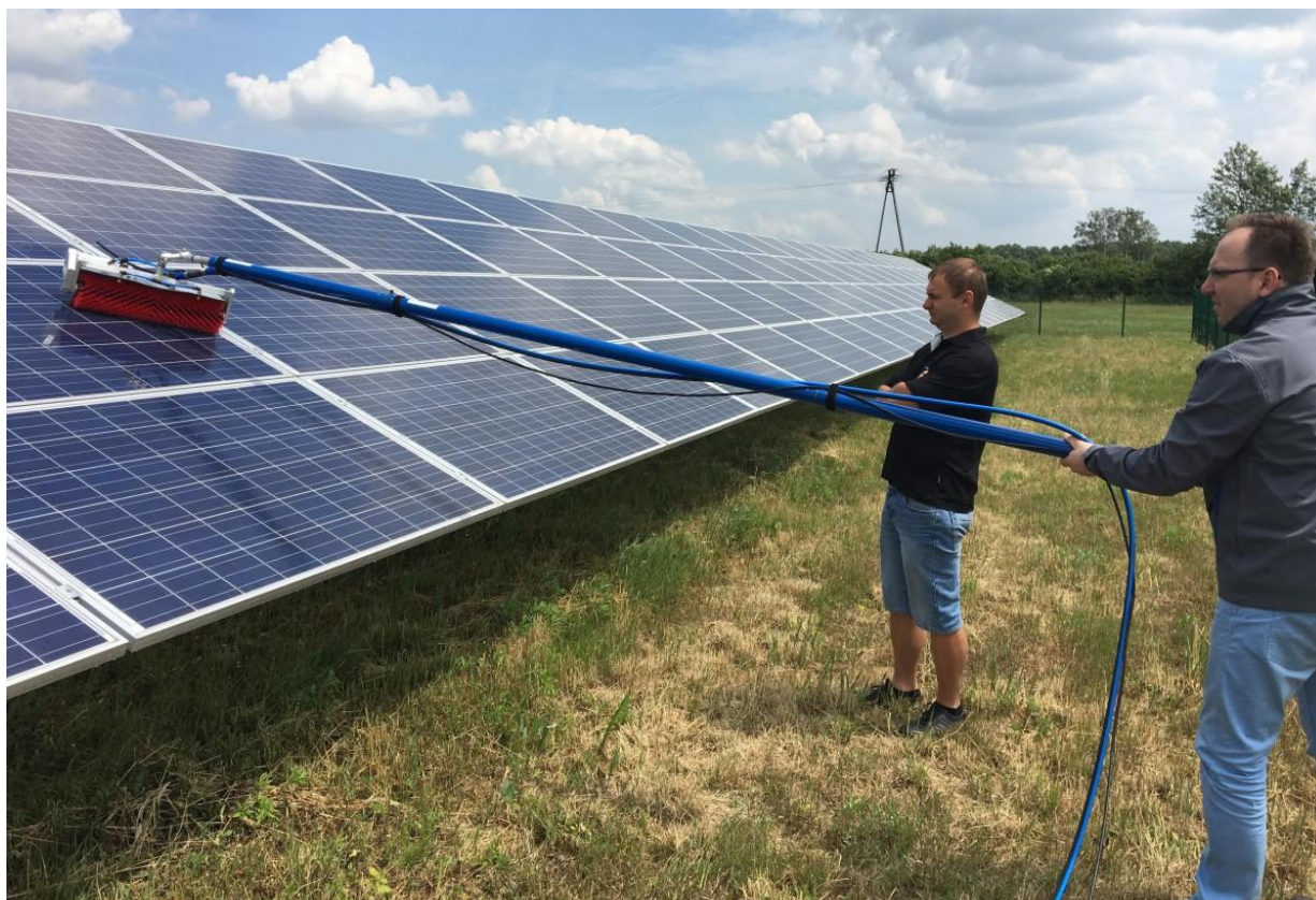
Zdj. 11 Mycie paneli fotowoltaicznych
