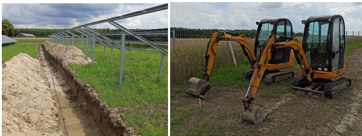
Zdj. 12 Płytki wykop pod okablowanie instalacji oraz koparki do prowadzenia prac
