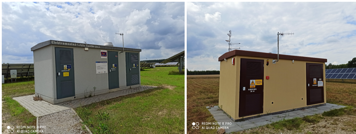
Zdj. 3 Funkcjonujące kontenerowe stacje transformatorowe
