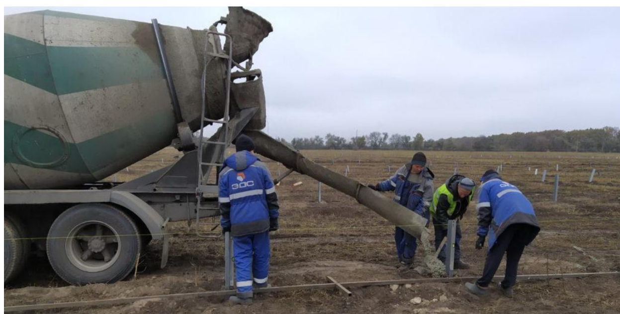
Zdj. 23 Zalewanie betonem fundamentów konstrukcji pod panele PV
