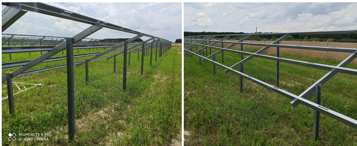
Zdj. 8 White słupy z zamocowanymi elementami szkieletu
