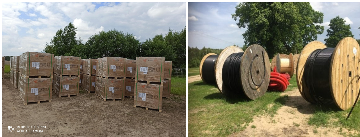
Zdj. 9 Materiały do budowy farmy PV przywiezione na plac budowy
