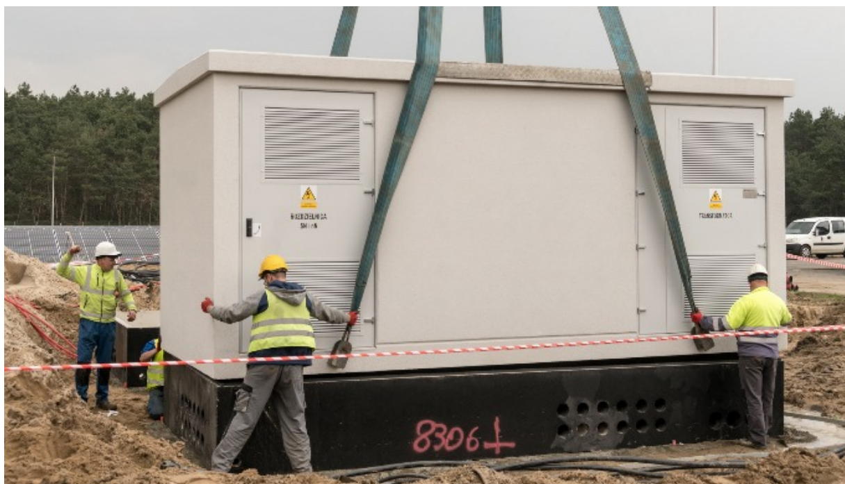
Zdj. 10 Montaż stacji trafo na płycie fundamentowej
