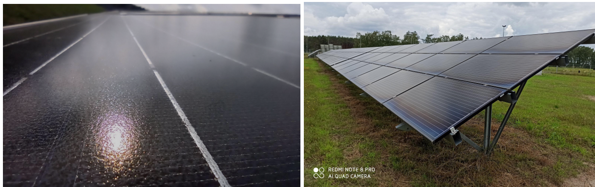
Zdj. 36 Struktura panelu PV - porowata i pokryta warstwą antyrefleksyjną
