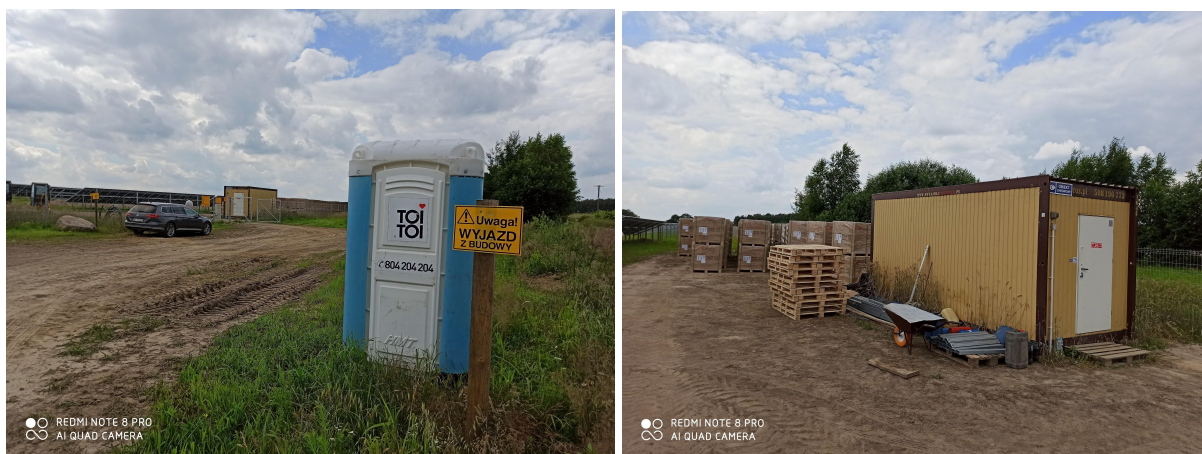
Zdj. 44 Plac budowy, zaplecze socjalno - bytowe
