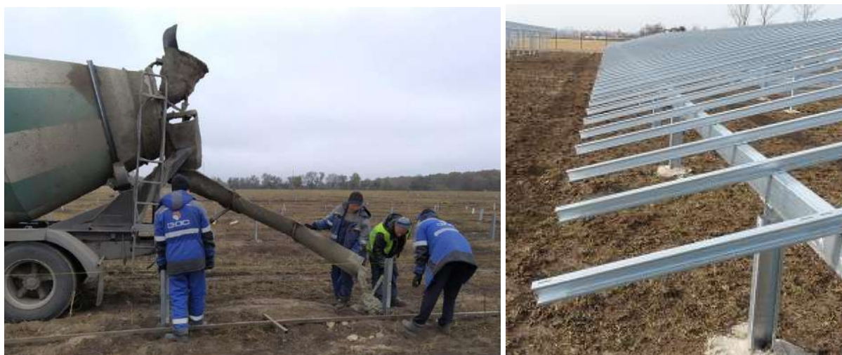
Rys. Konstrukcja zakotwiona w betonie
