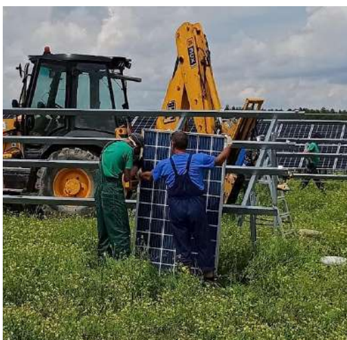
Zdj. Teren budowy - montaż elementów farmy PV
