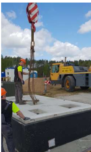
Zdj. Montaż płyty fundamentowej i stacji trafo na płycie fundamentowej
