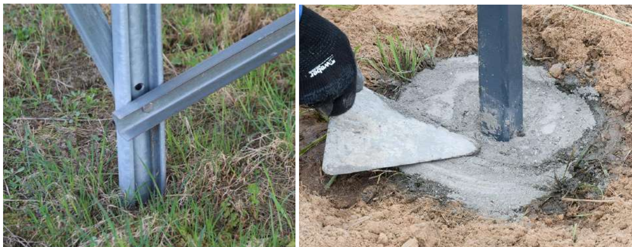
Zdj. Różnice w sposobie kotwienia - istotne z punktu oddziaływania na środowisko
