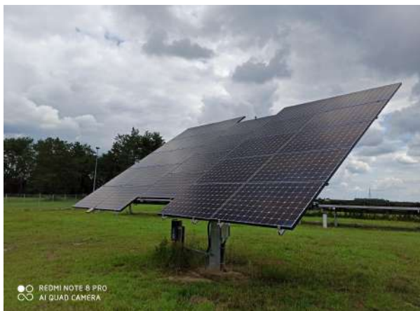
Zdj. Konstrukcja nośna paneli PV - standardowa i oparta na trackerach.
