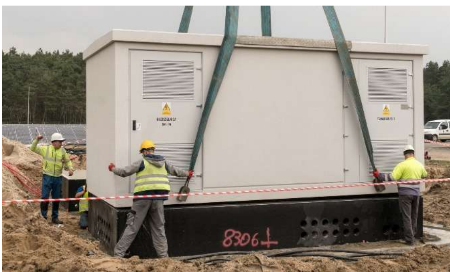
Zdj. Montaż płyty fundamentowej i stacji trafo na płycie fundamentowej
