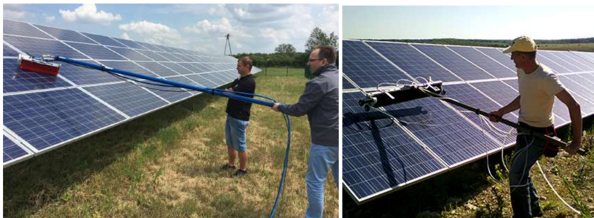
Zdj. Mycie paneli fotowoltaicznych
