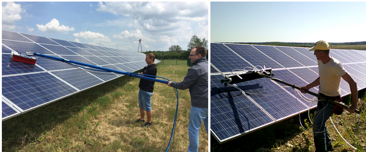
Zdj. 13 Mycie paneli fotowoltaicznych
