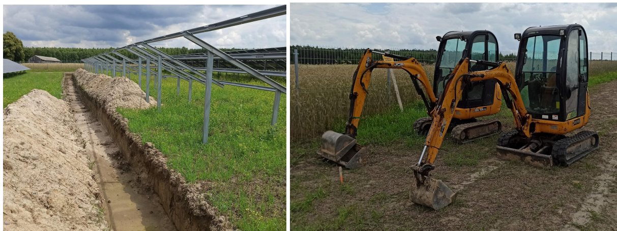
Zdj. 14 Wykop pod okablowanie instalacji oraz koparki do prowadzenia prac
