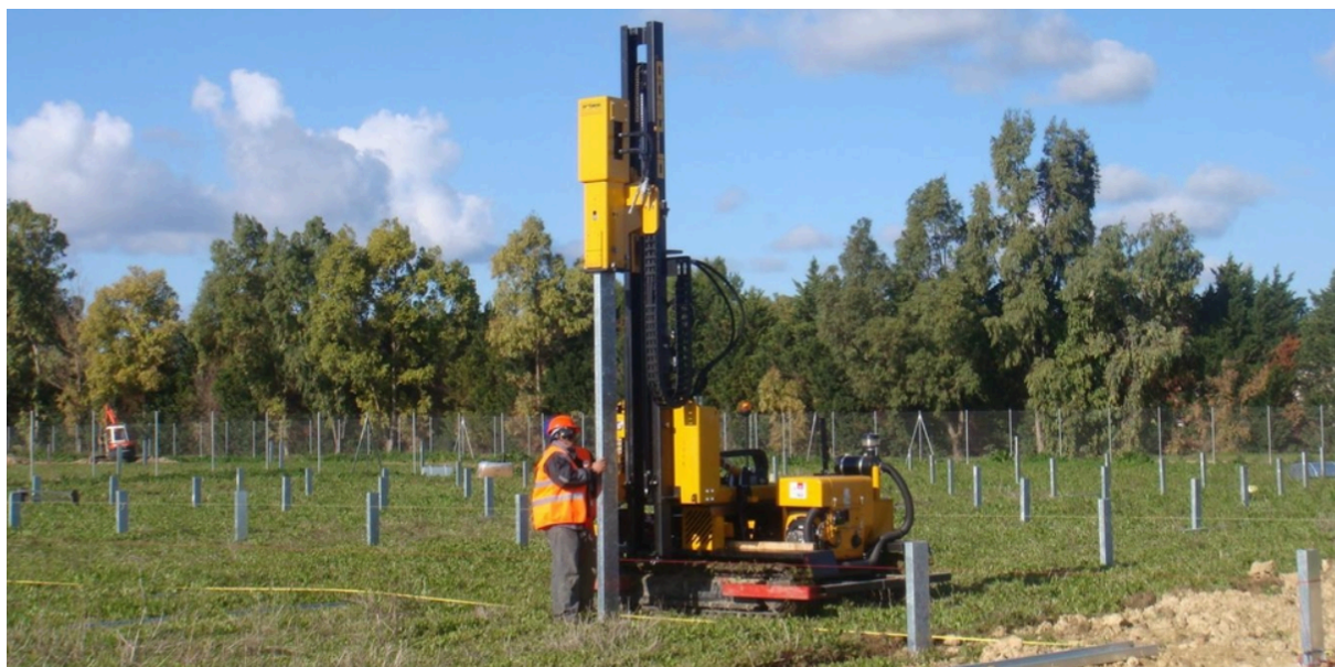
Zdj. 19 Wbijanie kafarem słupów pod konstrukcję wsporczą
