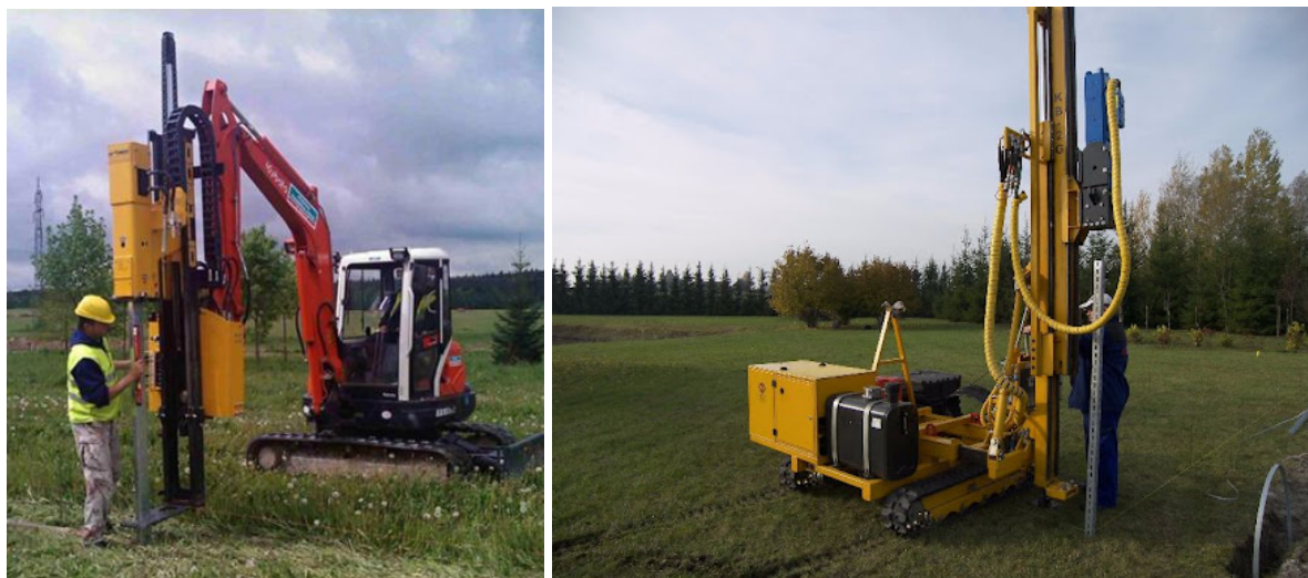
Zdj. 32 Kafar do wbijania słupów konstrukcji wsporczej
