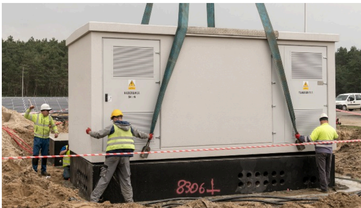
Zdj. 12 Montaż stacji transformatorowej na płycie fundamentowej
