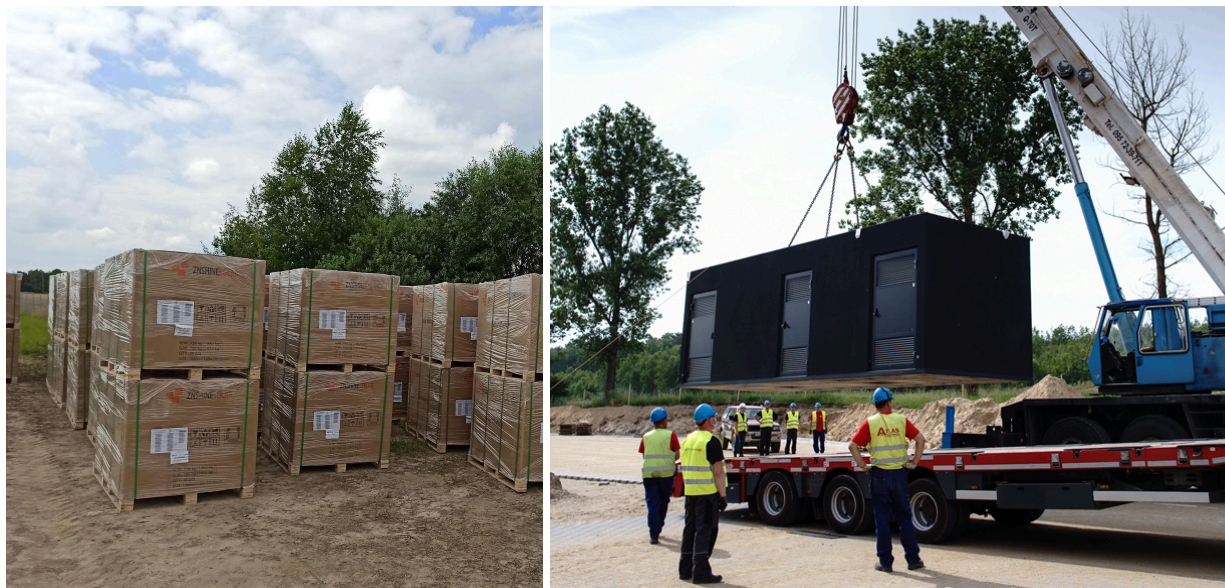
Zdj. 11 Elementy farmy PV przywiezione na plac budowy
