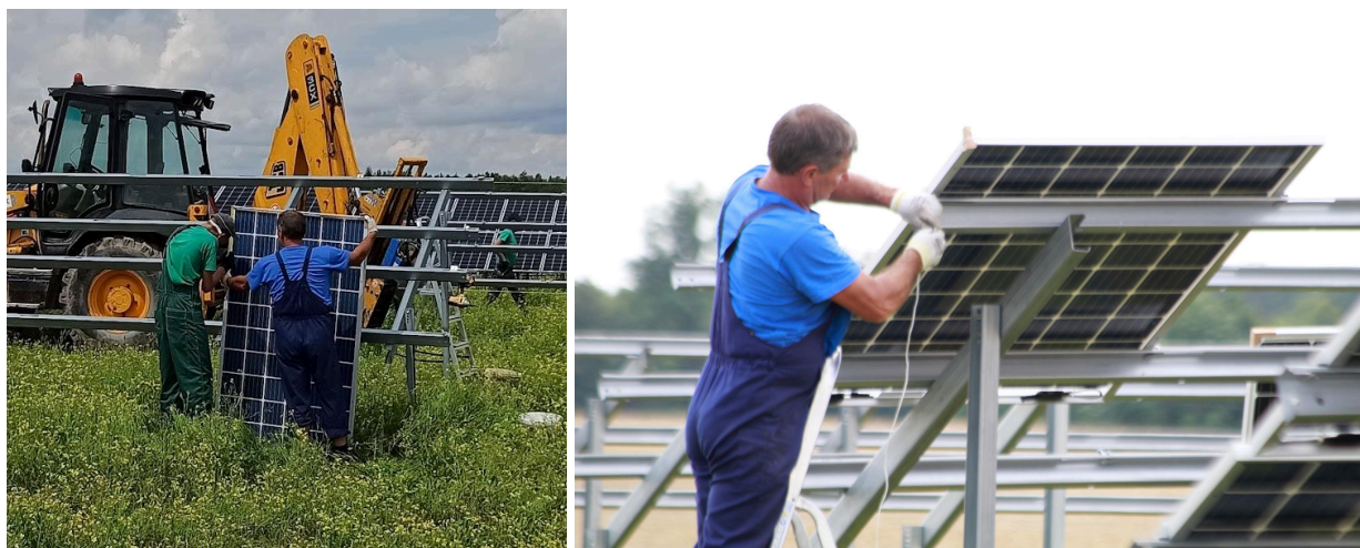
Zdj. 15 Teren budowy - montaż elementów farmy PV
