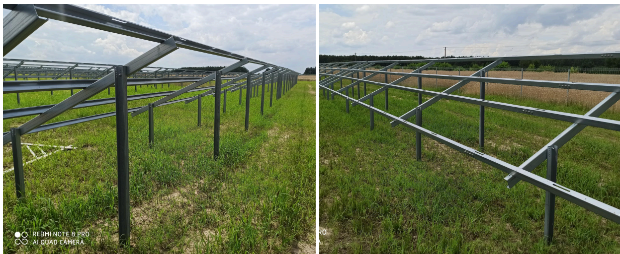
Zdj. 10 White słupy z zamocowanymi elementami szkieletu
