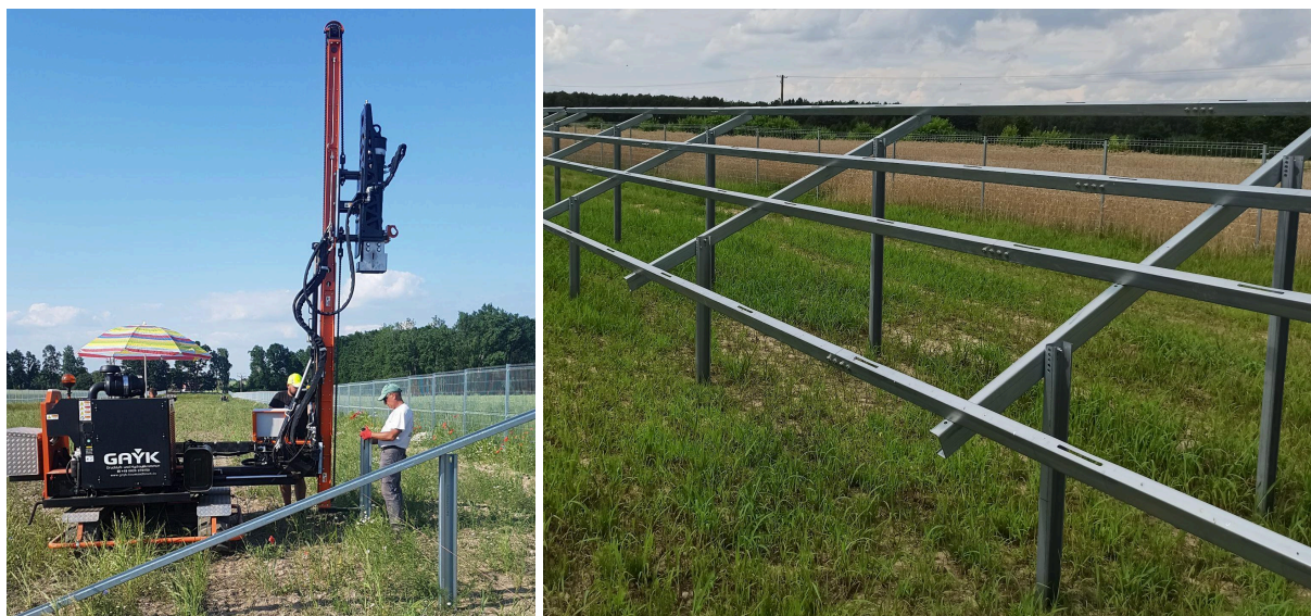
Zdj. 2 Konstrukcja wsporcza - słupki wbijane w grunt
