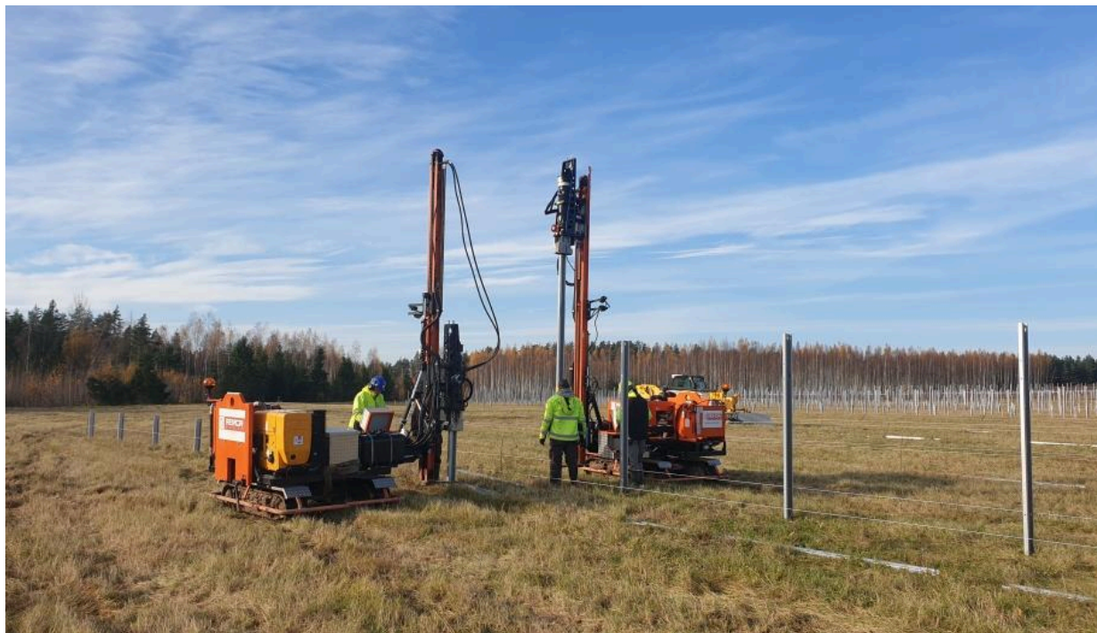
Zdj. 22 Wbijanie słupków konstrukcji wsporczej
