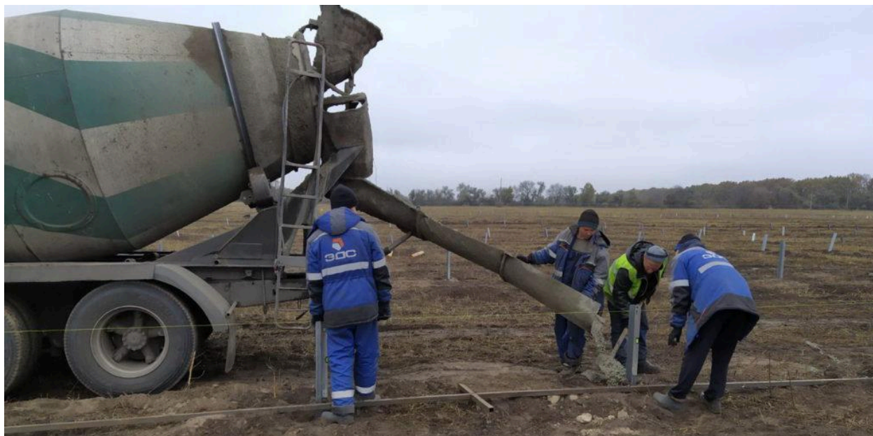
Zdj. 20 Zalewanie betonem fundamentów konstrukcji pod panele PV
