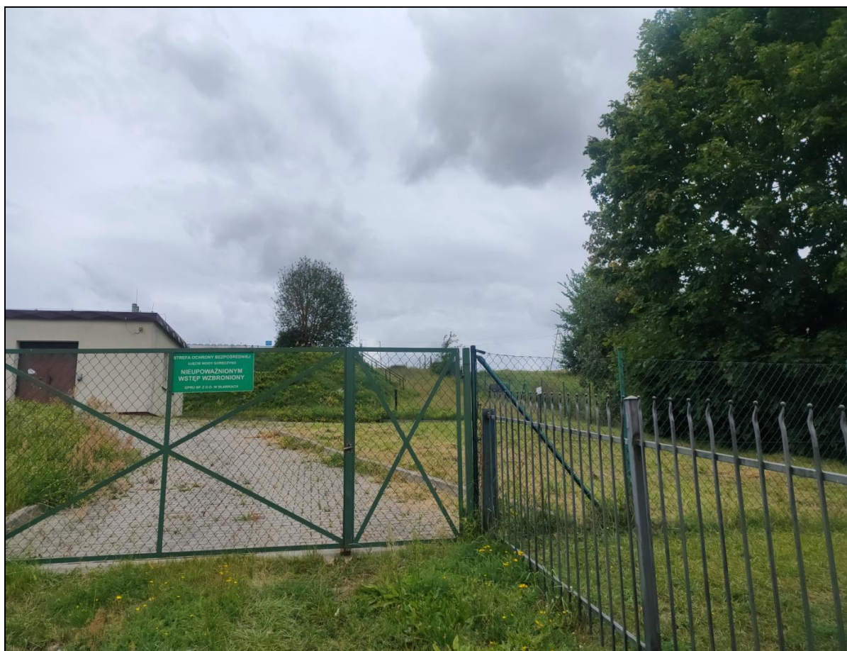
Ryc. 11. Ujęcie wody ze strefą ochronną w miejscowości Goręczyno
